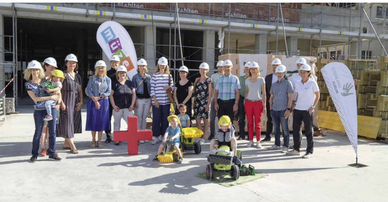
Baustellenbesuch mit den zukünftigen Mietern
